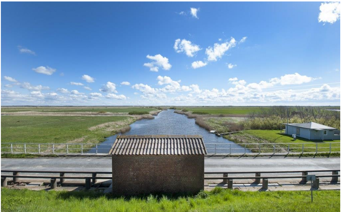
Foto 3. Placering af Sandfang 3. Foto: Esbjerg Kommune.
