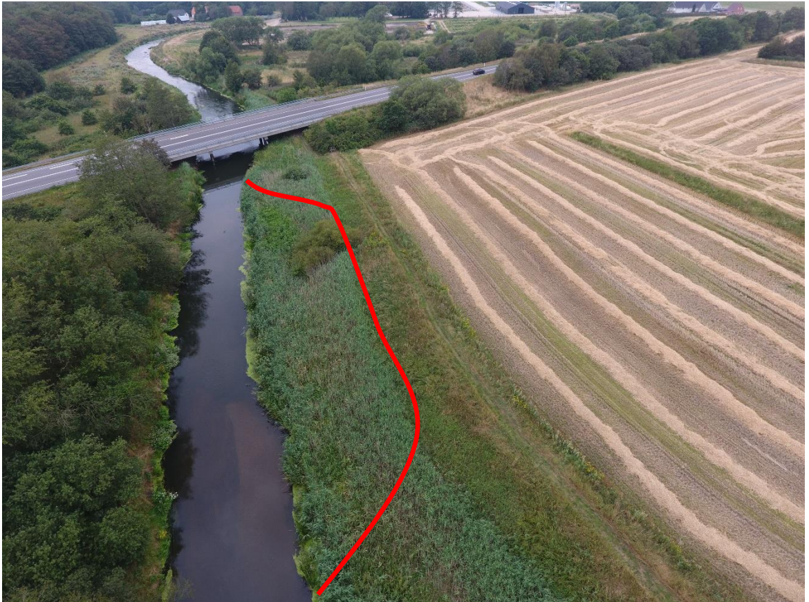
Foto 1. Placering af Sandfang 1. Udvidelsen er angivet med rød linje (omtrentlig placering). Foto: Esbjerg Kommune.
